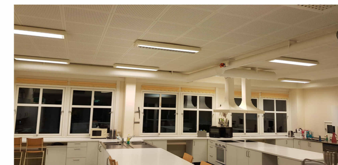
Avtrekkskanaler fra kjøkkenhetter rives. Kjøkkenhetter demonteres og remonteres.
