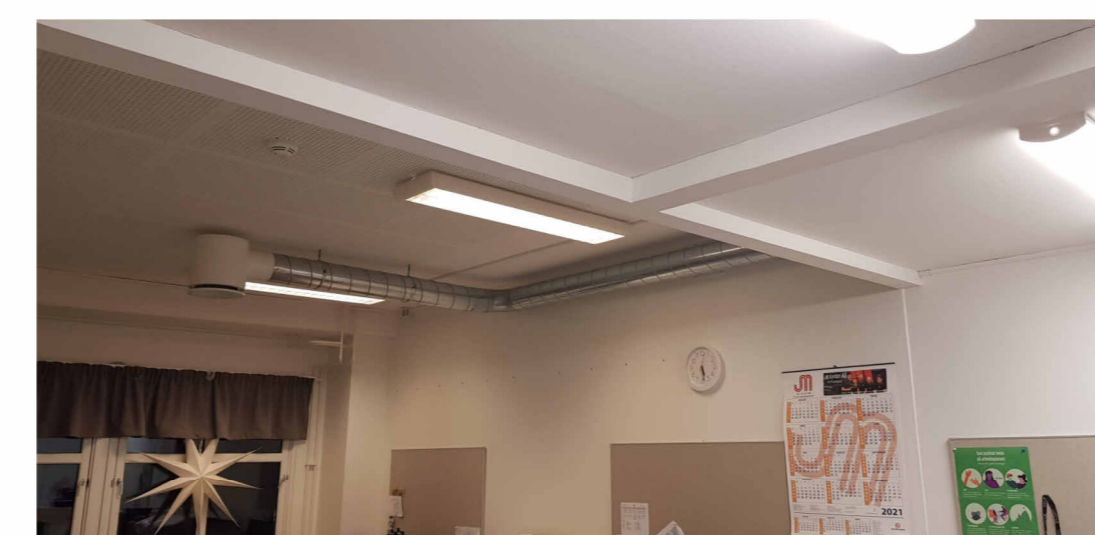
Åpen ventilasjon i A236b rives
