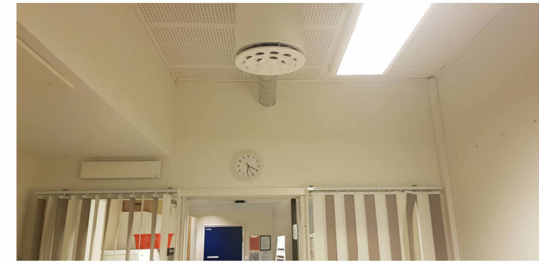
Åpen ventilasjon i A251 rives
