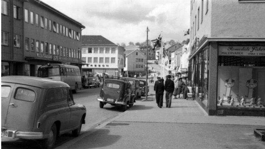
Et enhetlig arkitektonisk uttrykk og 3 etasjers bygg preger gatebildet på 50-tallet.
