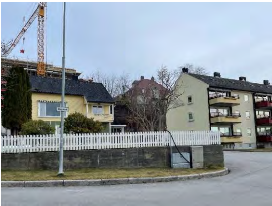
Boligblokk i småhusområde der asfalten dominerer utearealene
