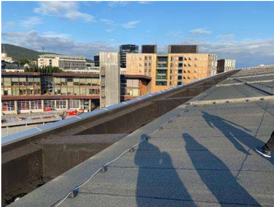
Figur 2: Bilde fra taket av bygget som viser taknedløpet langs hele den vestlige kanten.
