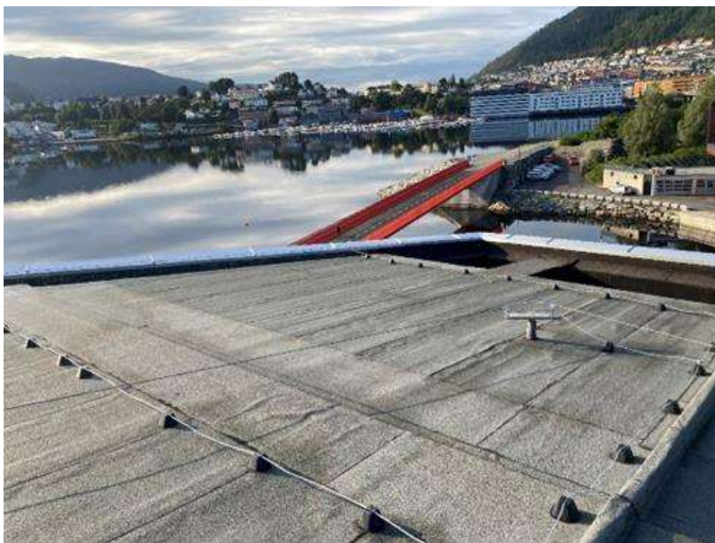
Figur 3: Bilde av sørvestlig hjørne av taket som laveste punktet på taket, avslutning av taknedløpet og vaieren for sikring som går rundt hele taket.
