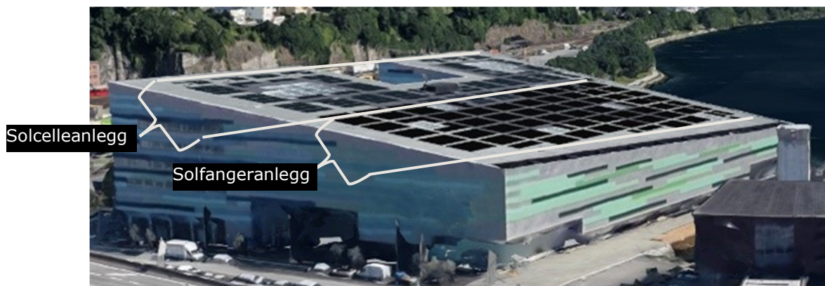
Figur 1: Ca. oversikt over solvarmeanlegget på tak. Solcelleanlegget utgjør ca. 1/3 av samlet installasjon.
