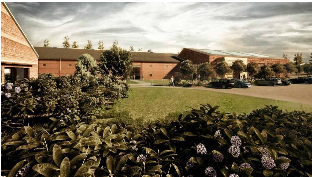
Figur 24. Utvidet anlegg sett fra sør
