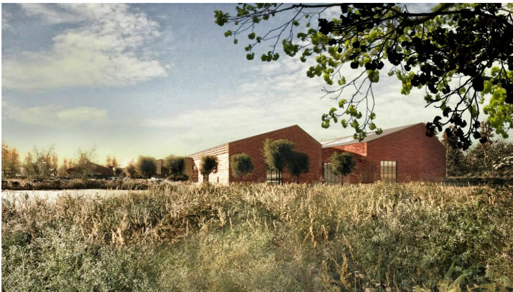
Figur 26. Nybygg sett fra øst
