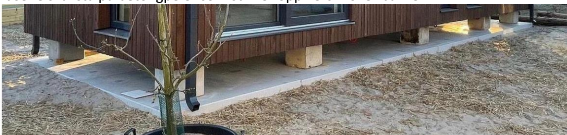
1 Eksempel på betongpeler husene skal stå på.
