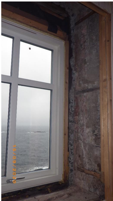
Bilde nr 10 – Innvendig i bolig-nytt vindu
