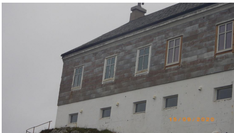
Bilde nr 4 – Vestre del av søndre fasade
