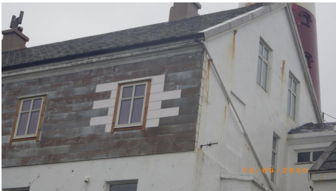
Bilde nr 5 – Østre del av søndre fasade
