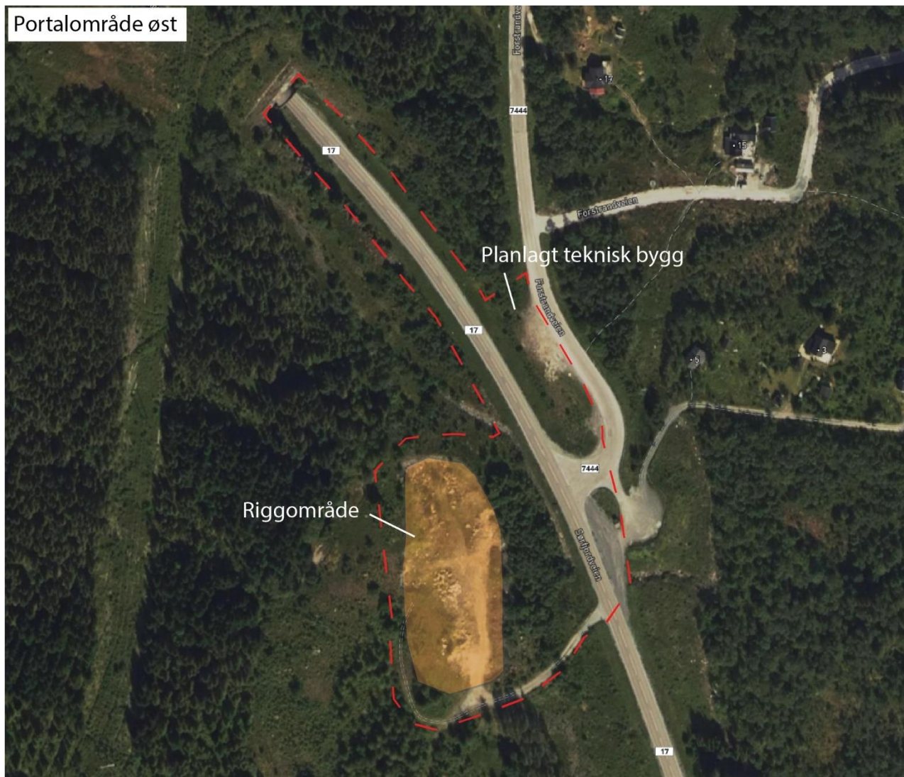
Figur 3: Oversikt over tiltaksområdet øst for tunnel.
