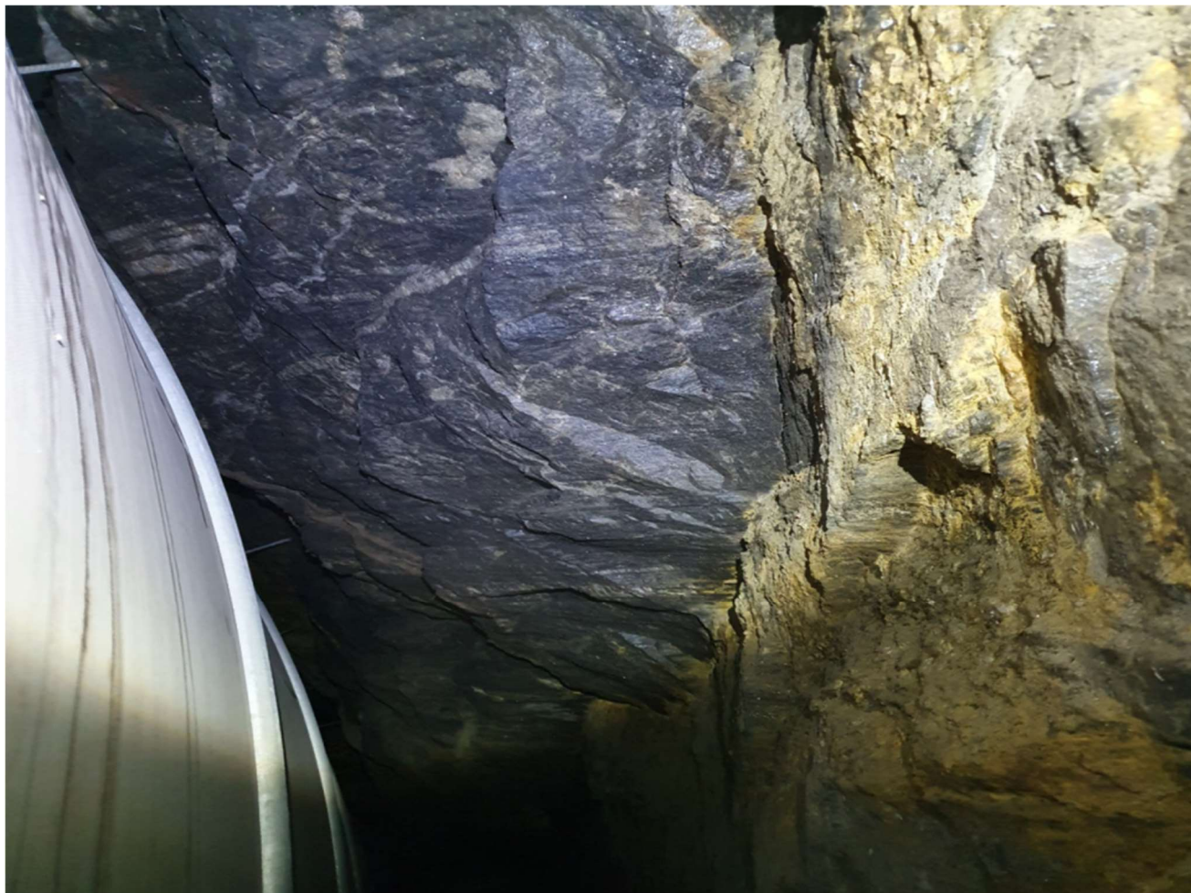
Figur 1: Sovelutfelling på bergvegg. Foto fra tidligere ingeniørgeologisk kartlegging.
