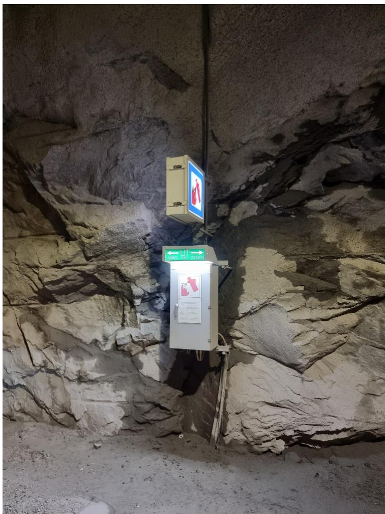
Figur 1: Oppheng for brannslukningsapparat med tilhørende lys som er EE-avfall.
