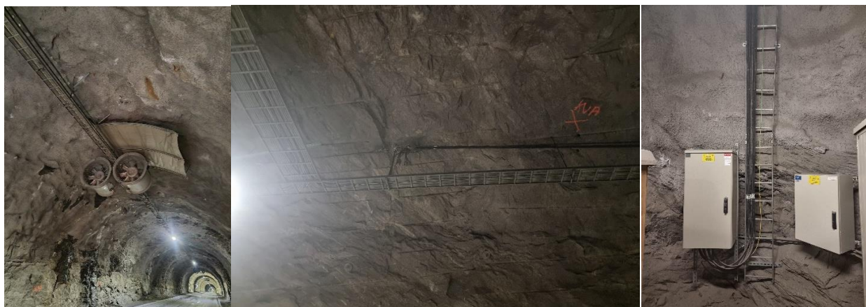
Figur 2: Eksempler på EE-avfall i tunnelen. Fra venstre vifter, kabelkanaler og el. bokser.
