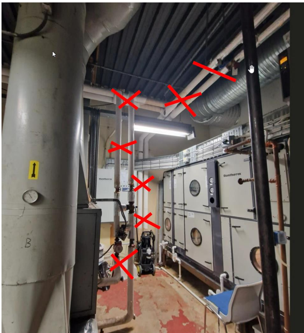
(Bildet viser rør som skal demonteres)
