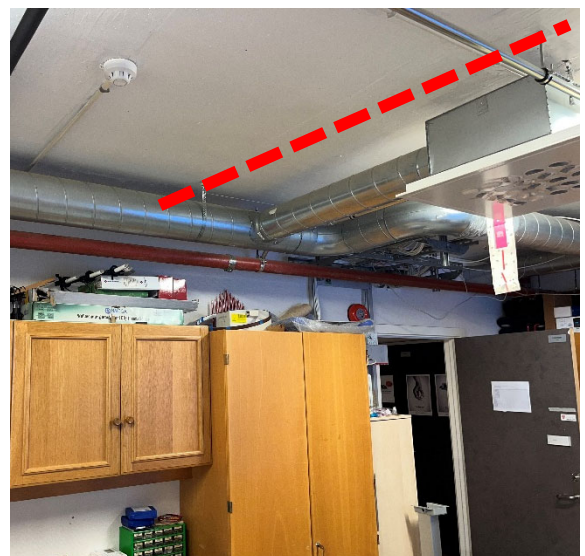
Bilete 04. Vaktmesterrom. Innervegg mot gang
