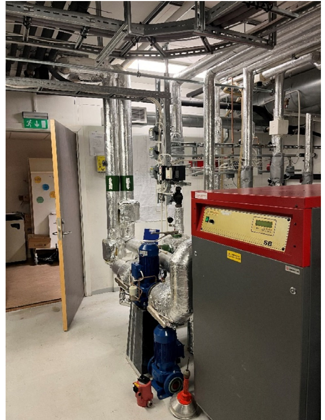
Bilete 08. Teknisk rom. Dør mot gang
