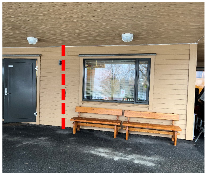
Bilete 02. Yttervegg inntak. Markert vertikal rørføring
