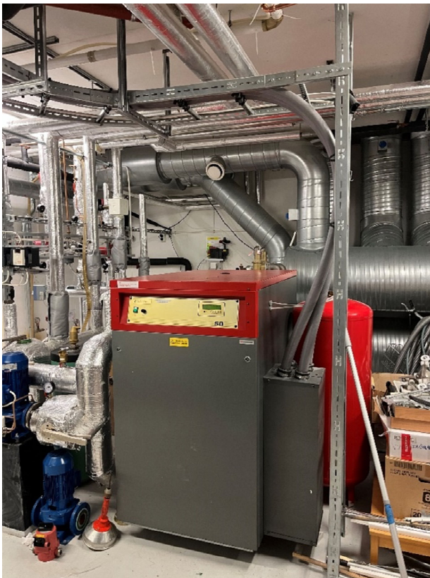
Bilete 07. Teknisk rom. Eksisterende el-kjel
