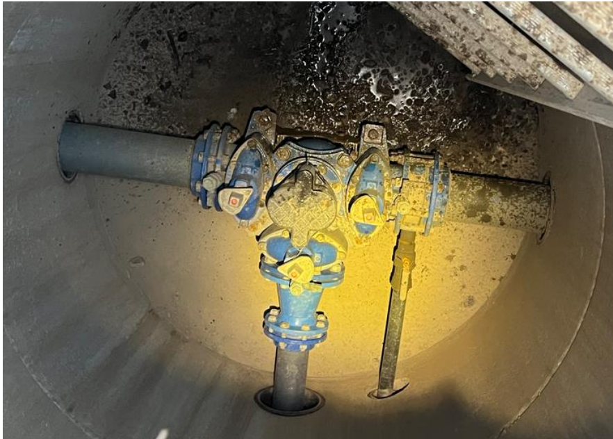
Figur 1: Bilde av eksisterende brannkum. Ventil-T skal byttes med nytt ventilkryss i eksisterende kum. Opp på bildet er retning nord.
