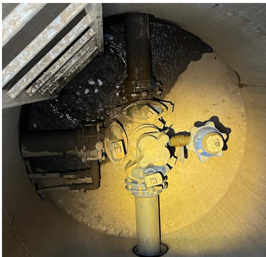
Figur 1: Bilde av eksisterende kum. Opp på bildet er i retning nord.
