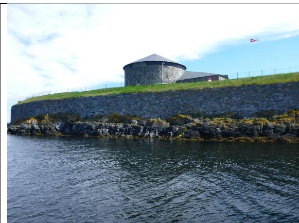
Oversiktsbilde Mur sone 6.
