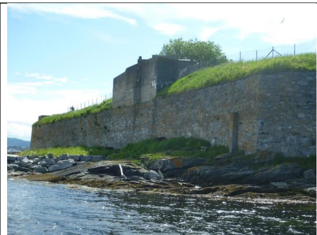
Oversiktsbilde Mur sone 3.
