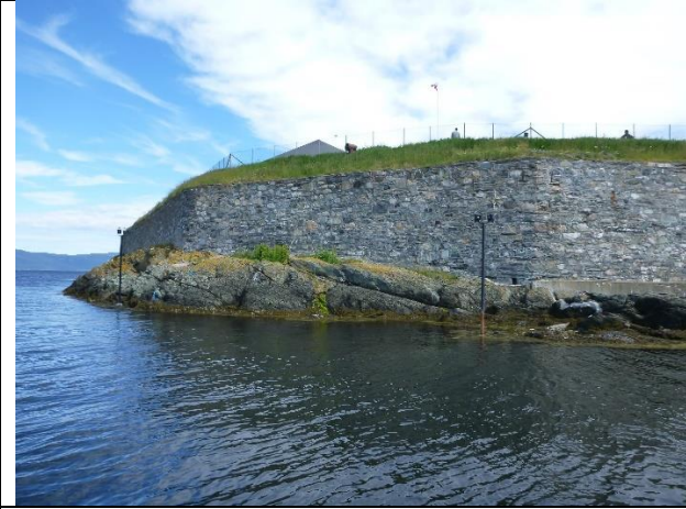
Oversiktsbilde Mur sone 7.
