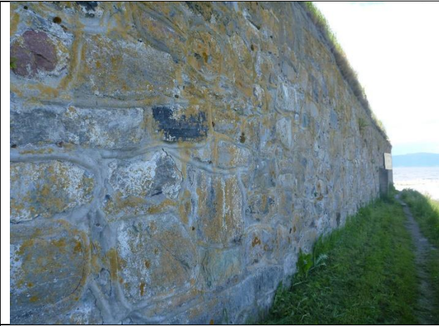
Oversiktsbilde Mur sone 2.
