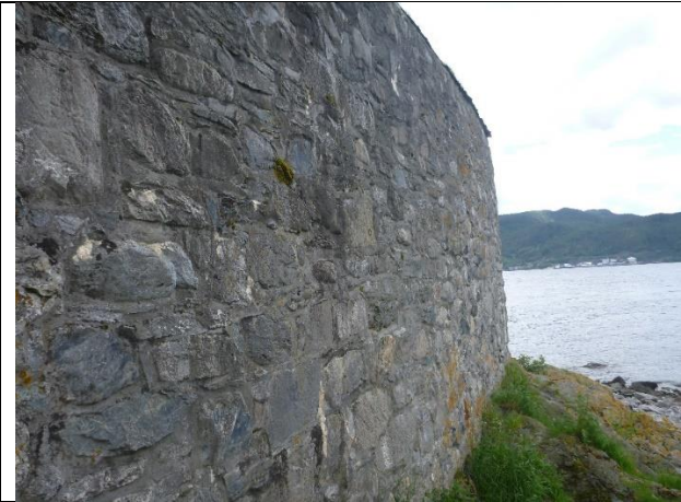
Oversiktsbilde Mur sone 4
