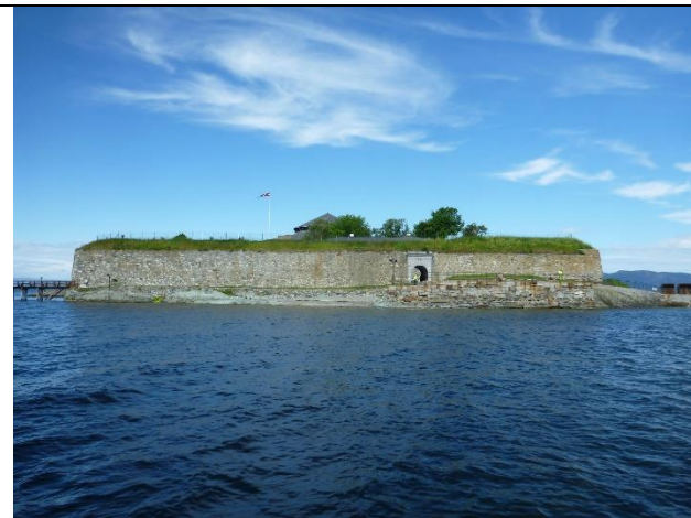
Oversiktsbilde Mur sone 1.
