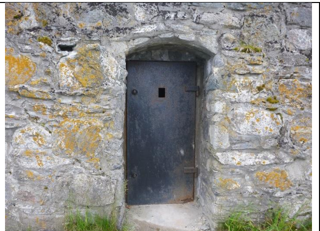
Ståldør i mur sone 4.
