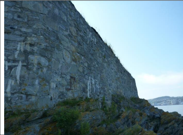
Oversiktsbilde Mur sone 5.
