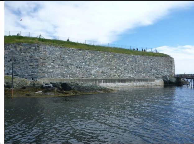
Oversiktsbilde Mur sone 8.
