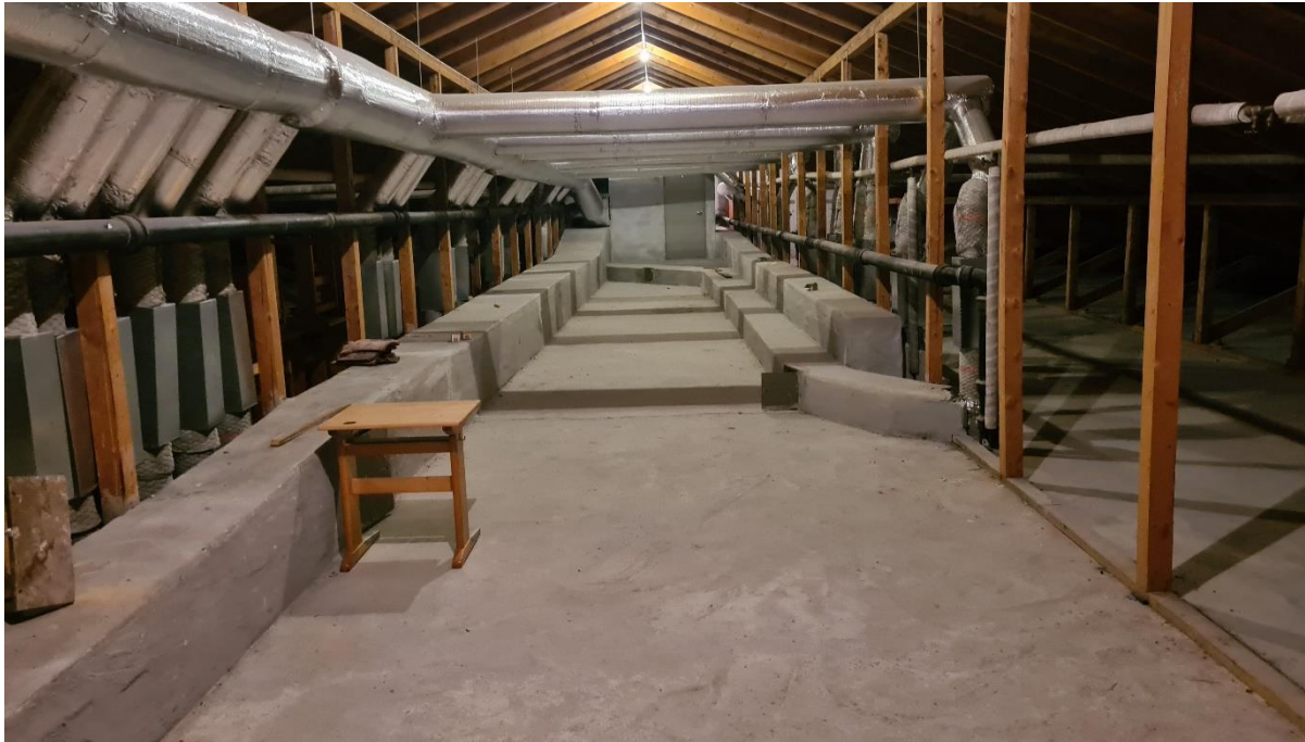
Bilde 1 – Søndre del av loftet, med murte kanaler på gulvet.
