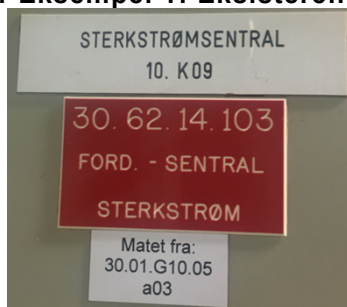
Figur 1 Eksempel 1: Eksisterende skilt
