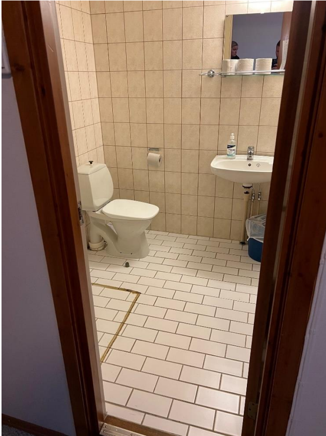
Bilde 3.5, viser forlegningsrom inngang bad, flislagt gulv og vegg
