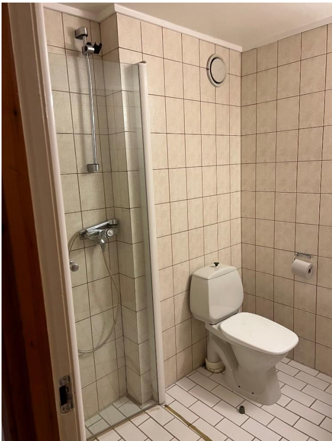
Bilde 3.6, viser bad i forlegningsrom, dusj, WC og avtrekksventil
