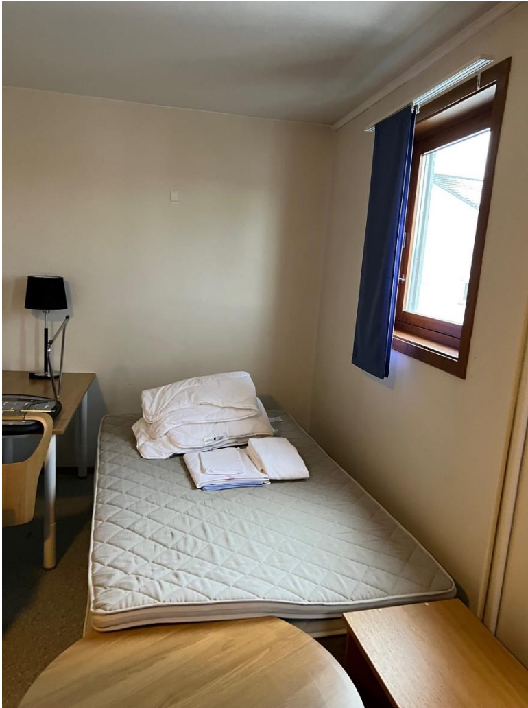
Bilde 3.3, viser forlegningsrom med vindu, radiatorrør og overgang til himling
