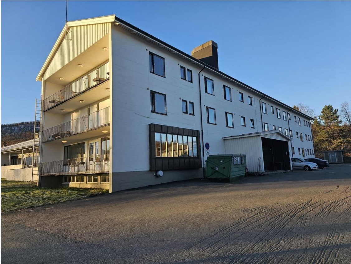
Bilde 1, viser fasaden på Rustad befalsforlegning «Senior»
