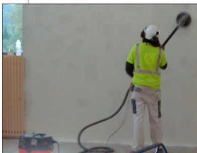
Pussemaskin påmontert støvavsug
