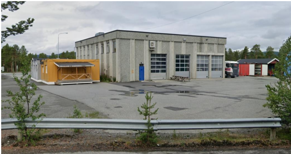
Bilde 1 – Aktuelle bygning, oppmøtested for tilbudsbeffaring. Bilde hentet fra Google Maps,
