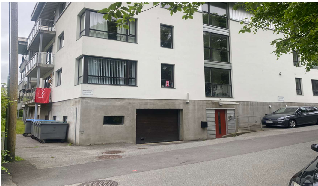
Bilde 2: Inngang garasje og hovedinngang blokk C
