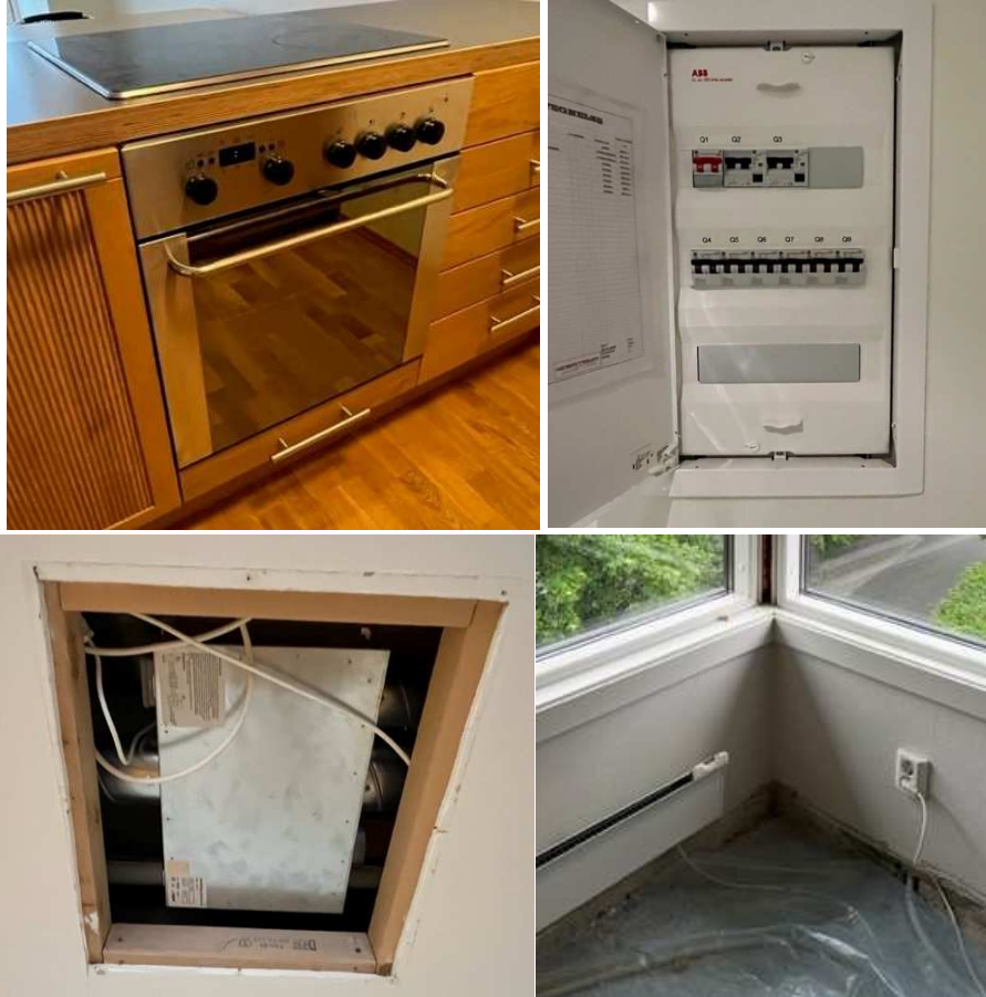
Bilde 3-6 Eksempler på EE-avfall i leilighetene som skal rives i 3. etasje i bygg C og bygg D.
