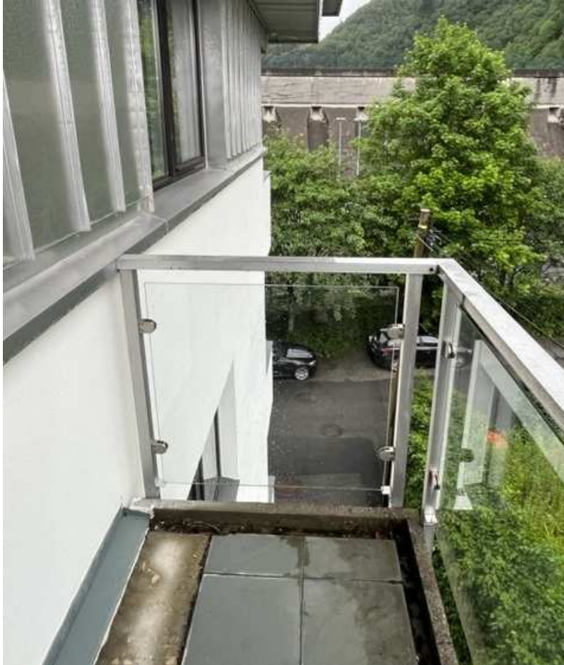
Bilde 1 Betong og flis i yttervegger og ved balkong 3. etasje.
