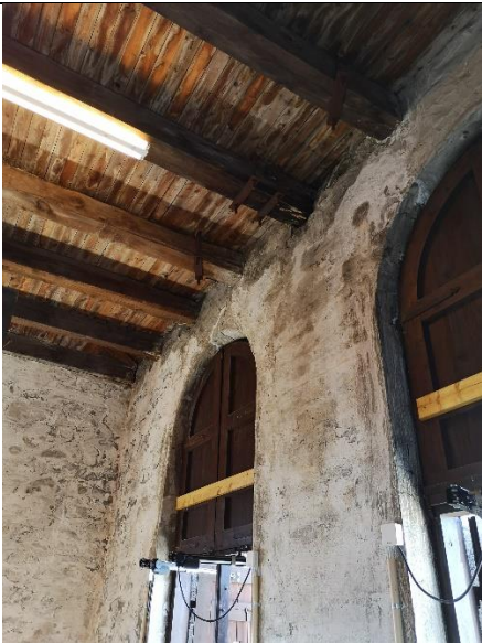
251-1: Bjelkelag i etasjeskille i tårnrom
