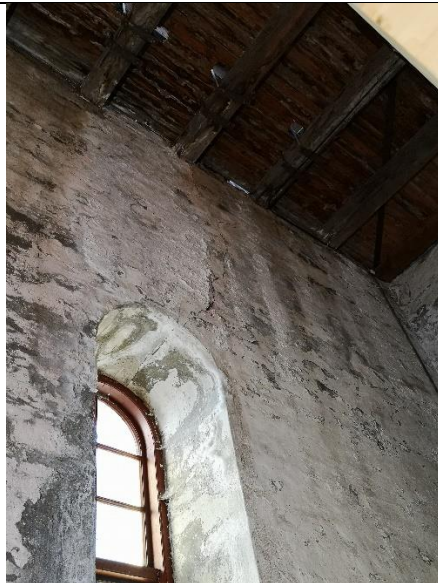
251-2: Bjelkelag i etasjeskille i tårnrom
