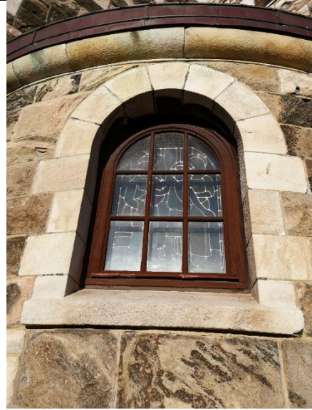
234-2: Eksempel på vindu med blyprosseverk på innvendig side.
