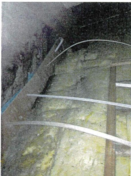
Det er no lagt opp kryssfinerplater med påstifta absorberende matter. Dette er ei naudløysing for å hindre meir av sotvatnet å komme ned i skipet.
