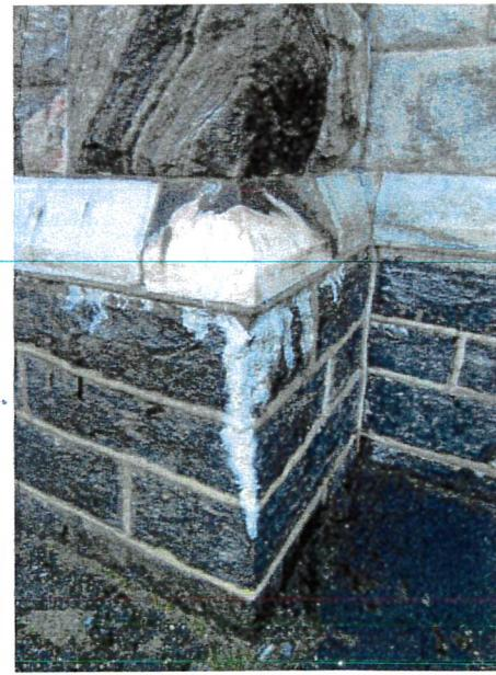
Avleiringer på yttervegger som viser at der er fuktvandring i murverket.
