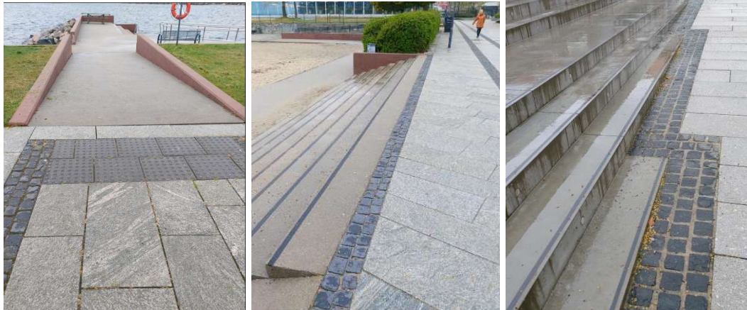
Overgang mot sjø/vei
