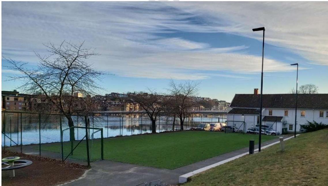
Belysning av balløkke. Armaturer plasseres fortrinnsvis slik, ved langsiden. Elveparken ved Kvadraturen. Foto Helmer Espeland
