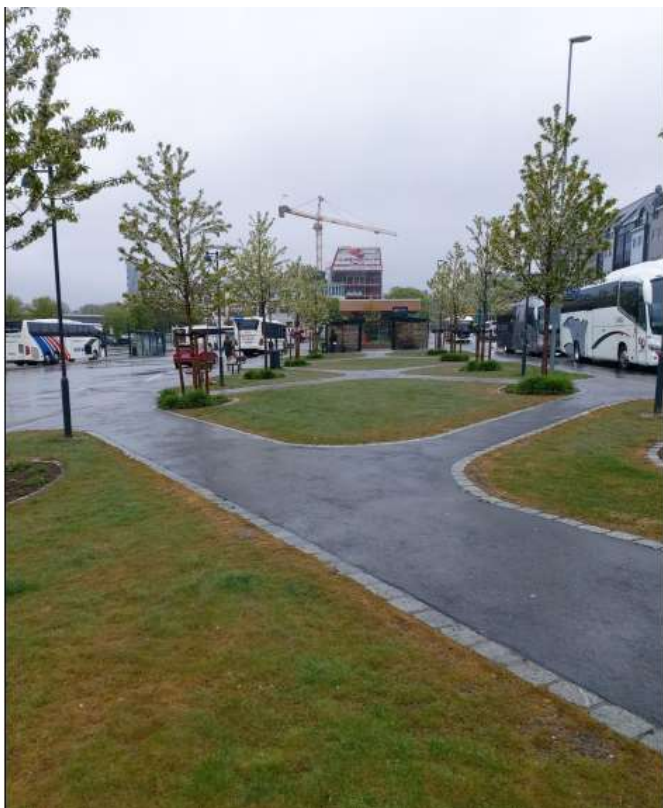
Driftsvennlig utforming av grøntanlegg med fast dekke på veier, alle kanter i plan med terreng, samt støpte gatesteinskanter rundt bed. Drenering til plener. Rutebilstasjonen 2022. Foto Helmer Espeland
