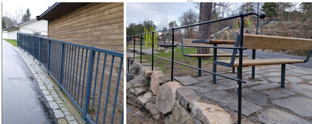
Eksempler på utførelse, hhv. klatresikkert rekkverk (Torridal gravplass) og «Sørlandsrekkverk» Peisestua på Odderøya. Foto Helmer Espeland
