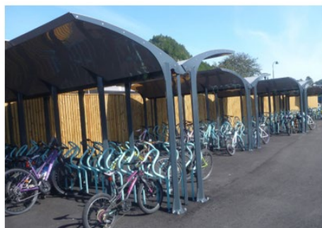
Sykkelparkering med takoverbygg, Mosby skole
