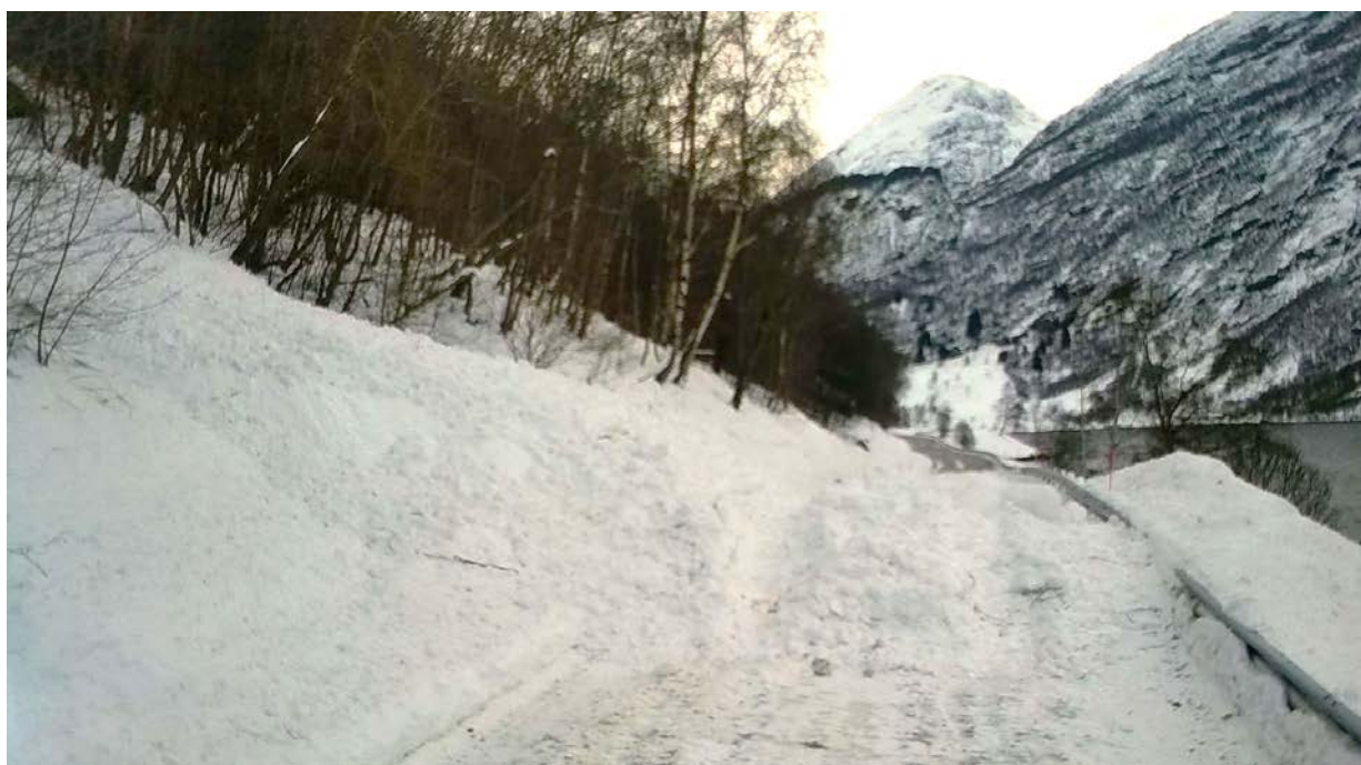
Figur 8. Sildesteinen i forbindelse med rydding etter skredet som gikk 30. januar 2019. Ca 120 m 3 snø ble liggende i vegen. Foto: Veidekke.
