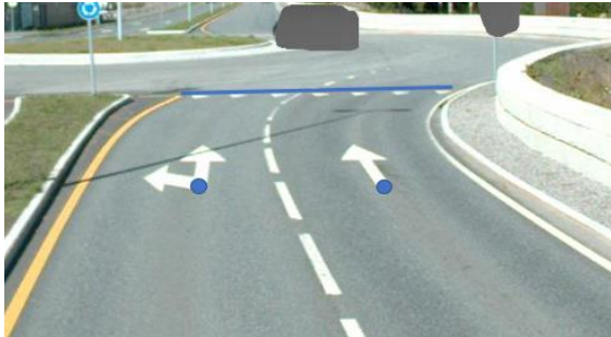
Figur 16. Eksempel: Vikelinje har kurve eller punkt ut fra type (spesifisert i Datakatalogen).
