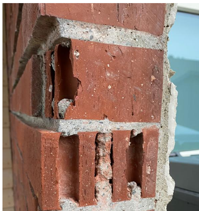
Bilde B4: P05 og P06 Tegl med mørtelfuger
