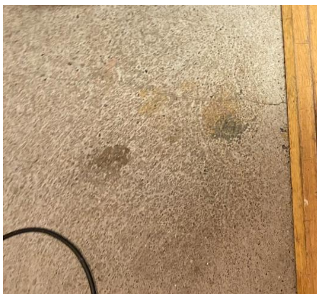
Bilde B3: P04 Betong på gulv i lager/kontor for vaktmester
