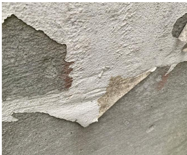
Bilde B5: P07 Prøve av utvendig maling på betongvegg på lager
