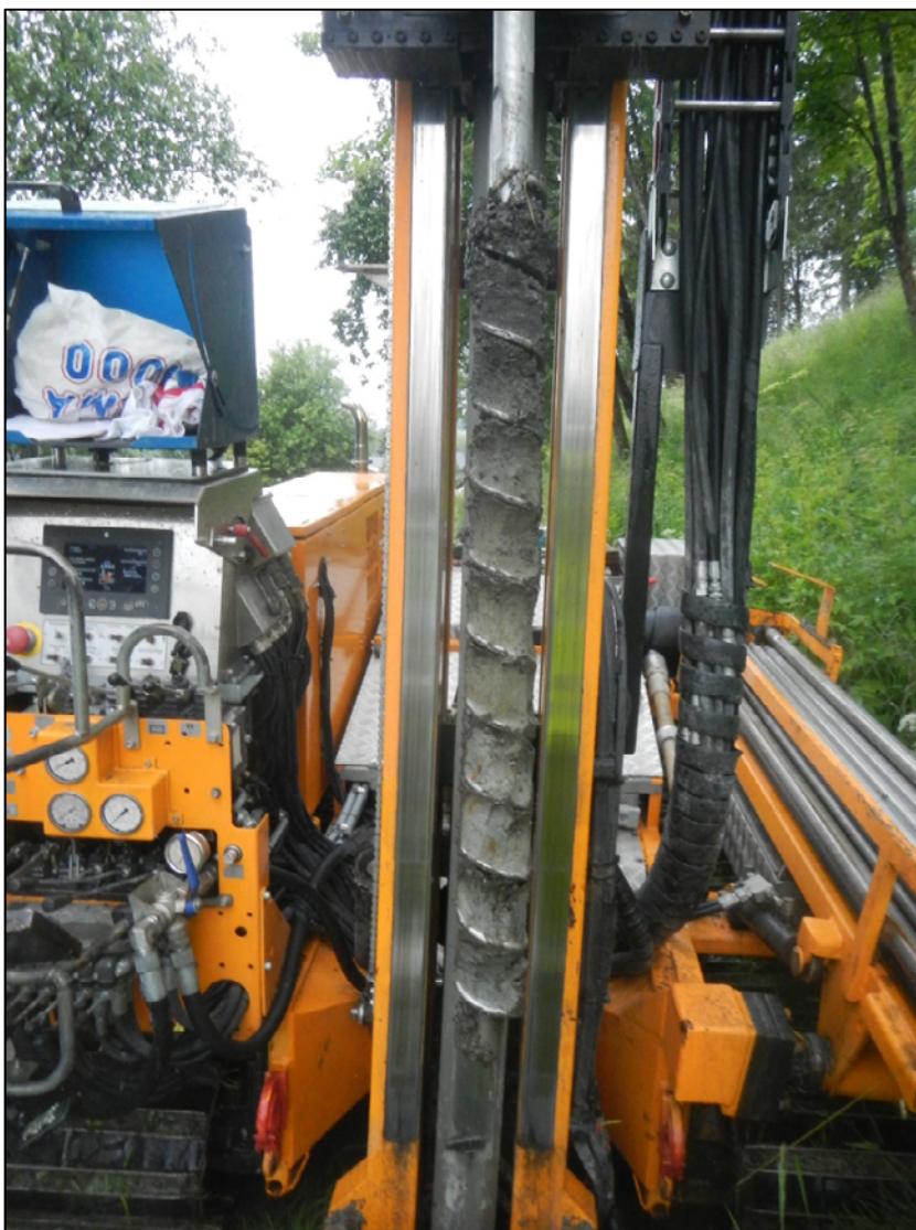
Figur 10. Skovl fra prøvepunkt GL15 0-1 meter, hvor det er registrert jord og leire over fyllmasse leire. Foto datert 1. juli 2019.
