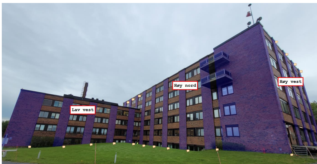
Figur 4 Illustrasjon av alle vertikale pilastere som er anbefalt re-fuget, markert i blått for fasade høy vest, høy nord og lav vest. Det samme gjelder fasade lav nord (vises ikke på bilde). Variasjoner kan forekomme, spesielt om opsjon for bygging av heishus på fasade høy vest blir utløst.
