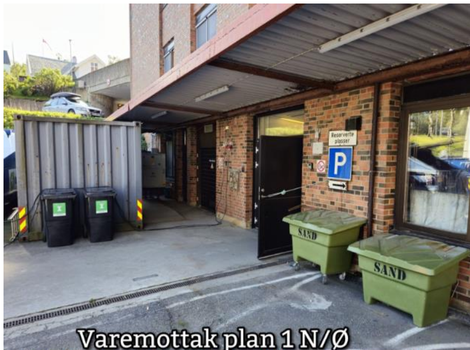
Figur 7: Fasade øst varemottak – takoverbygg rives og gjenoppbygges.
