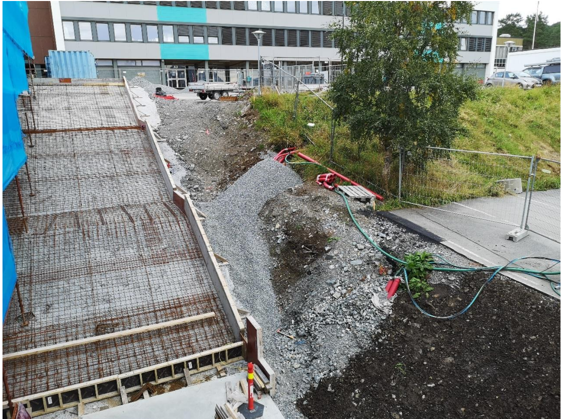
M – EI-kabel i grunn fra F-bygg til trafo A-bygg under byggeprosjektet for F.
