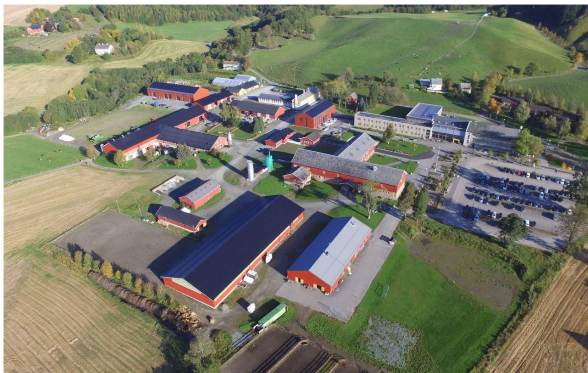
BILDE: Skjetlein videregående skole.
