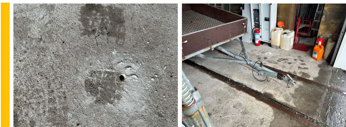
Figur 24 – Betong i gulv på grunn i garasje (P4).
