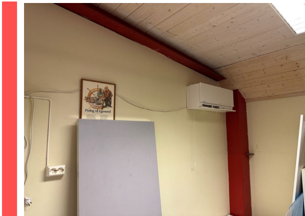
Figur 20 – Varmepumpe.
