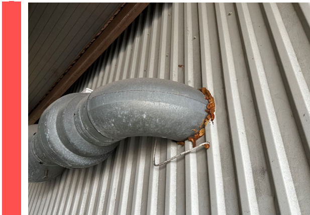
Figur 17 – Tetting med PUR-skum.
