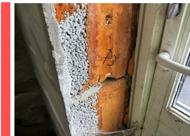
Figur 6 – Isolasjon i lettklinkerblokker (P3).
