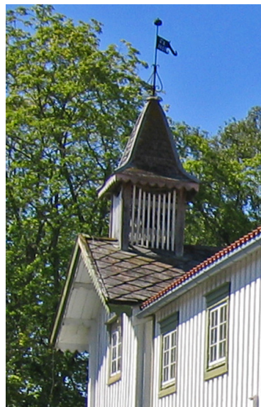
Klokketårn og skifertak. Opphavsrett: Statsbygg
