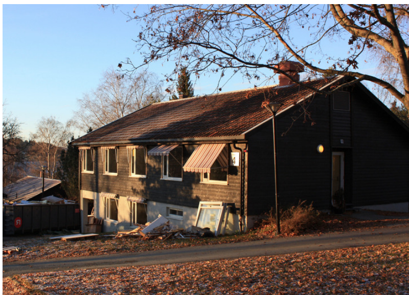
Paviljong 4. Soveromsetasje med binngang på gavlveggen. Opphavsrett: Statsbygg
