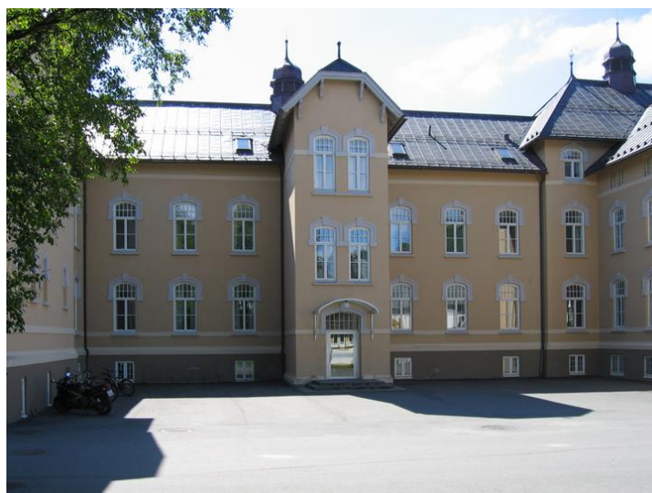
Inngangspartiet i nord-fasaden. Opphavsrett: Statsbygg
