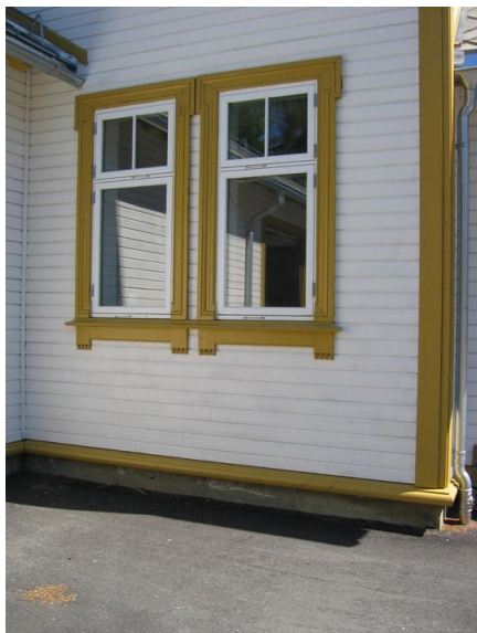
Veggdetalj med jugendpreget vindusomramming. Opphavsrett: Statsbygg
