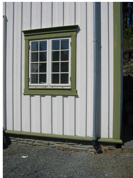
Detalj av vegg. Nyere vinduer. Opphavsrett: Statsbygg
