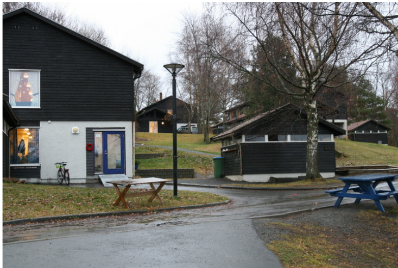
Paviljongene sett fra vest. Paviljong 6 med hovedinngang barnehage til venstre. Opphavsrett: Statsbygg.
