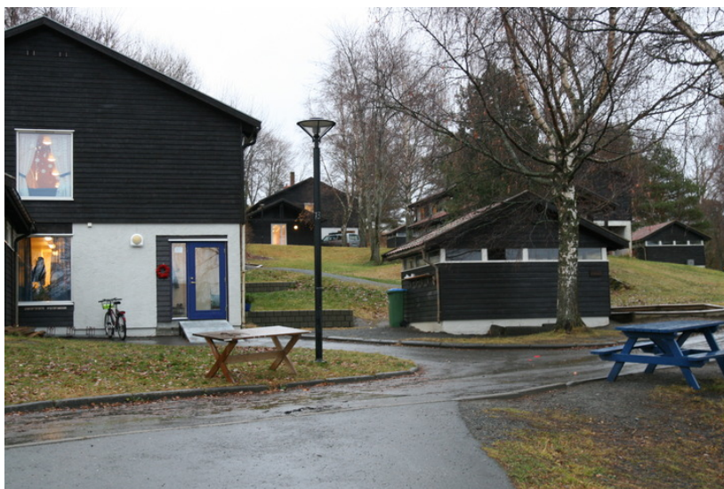
Paviljongene sett fra vest. Paviljong 6 med hovedinngang barnehage til venstre. Opphavsrett: Statsbygg.
