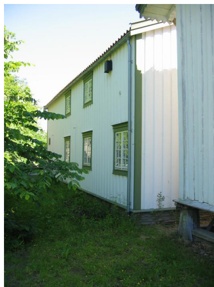
Nordfasade. Opphavsrett: Statsbygg
