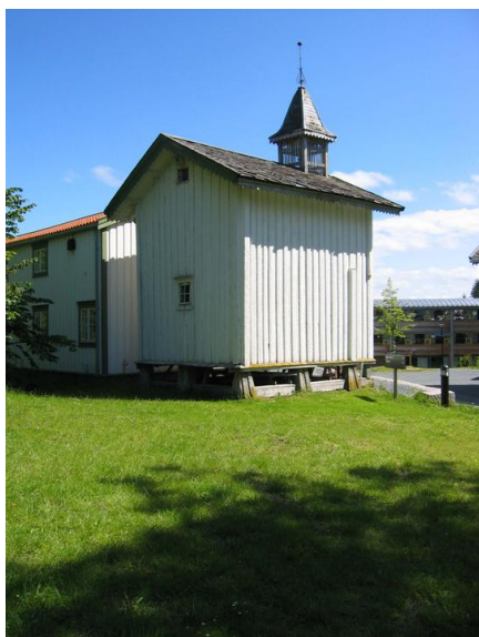
Fasader nord-vest. Opphavsrett: Statsbygg
