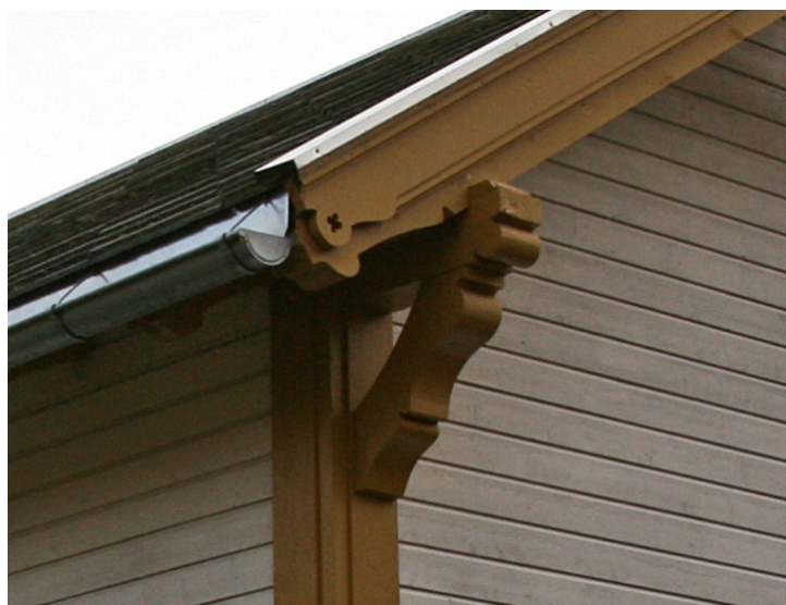
Detalj bjelkehoder. Opphavsrett: Statsbygg
