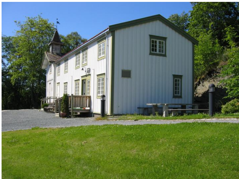
Sør- og østfasader. Opphavsrett: Statsbygg
