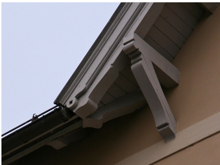
Detalj bjelkehoder. Opphavsrett: Statsbygg
