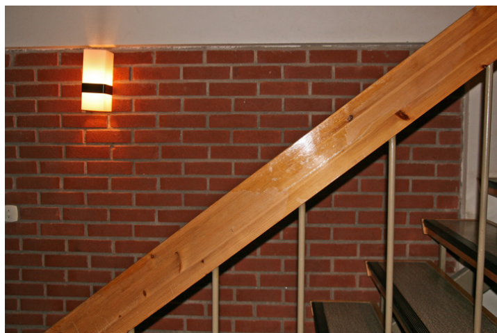
Detalj trapp og materialbruk. Opphavsrett: Statsbygg
