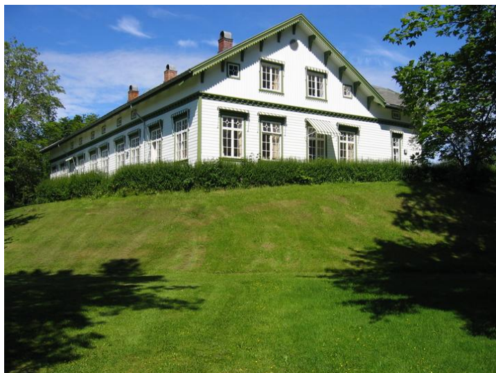
Vest- og sørfasader. Opphavsrett: Statsbygg
