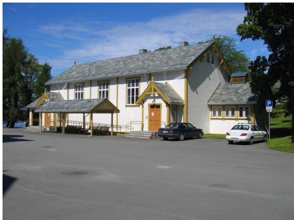
Sør- og østfasader. Opphavsrett: Statsbygg
