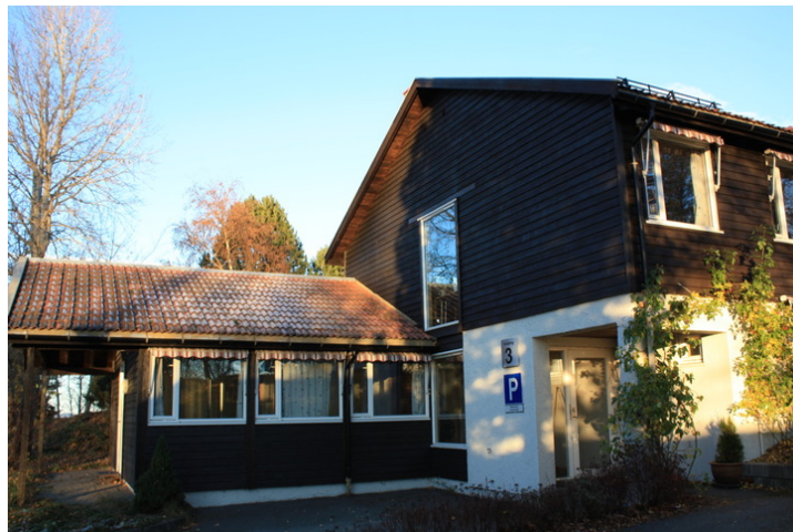
Paviljong 3. Hovedinngang til fellersom i sokkeletasje. Opphavsrett: Statsbygg
