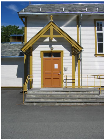
Inngangsparti med nyetablert rampe. Opphavsrett: Statsbygg
