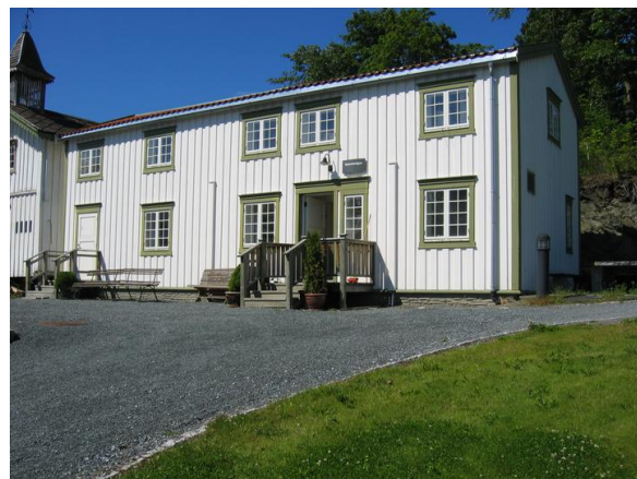
Fjøsmeisterboligen. Opphavsrett: Statsbygg
