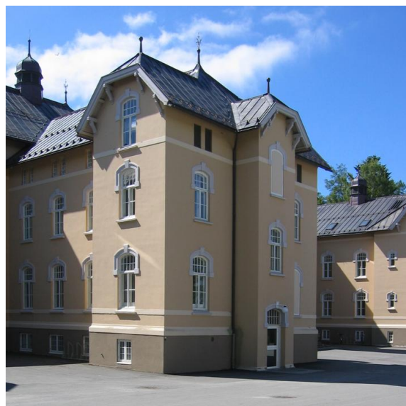
Midtre tverrføy mot nord. Foto: Trude Norddal Opphavsrett: Statsbygg
