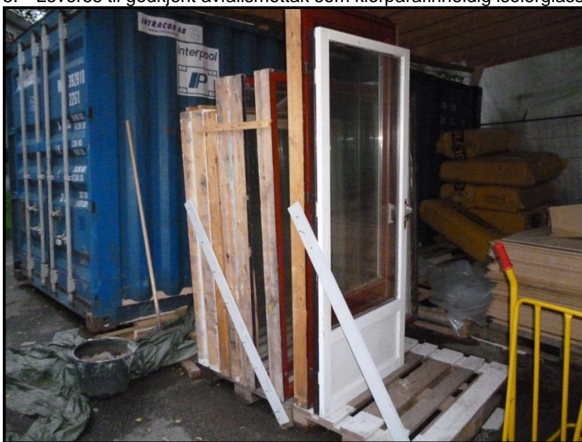
Figur 3: Slik kan vinduer og balkongdører klargjøres for transport.
