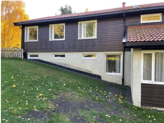
Dagens vindusløsning sokkel mot nord
