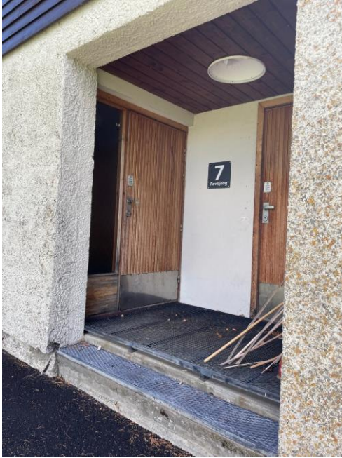
Dører i inngangsparti sokkel. Dør til grovvaskerom synes til høyre i bildet.
