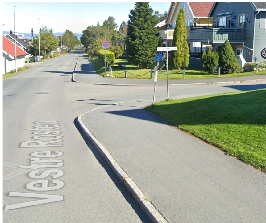
Holdeplass i nordgående retning: Det mangler taktil merking og kantstein er lav.
