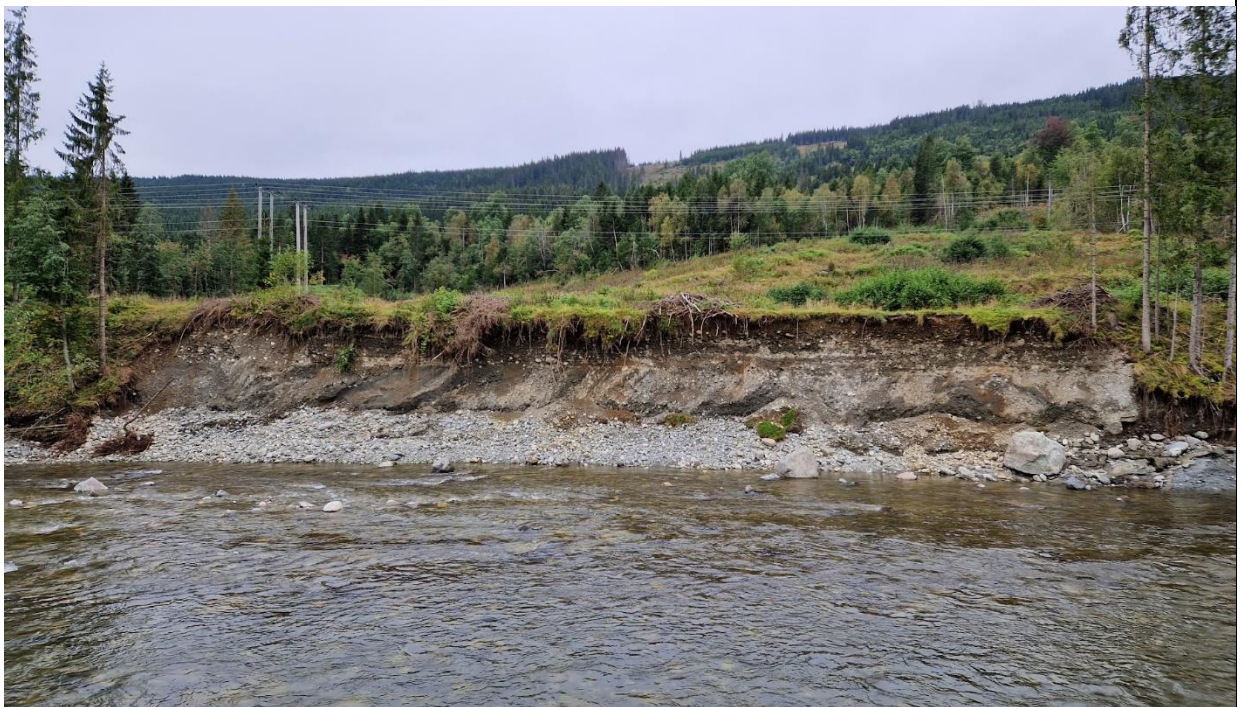
Store erosjonsskader på motsatt side av elva.
