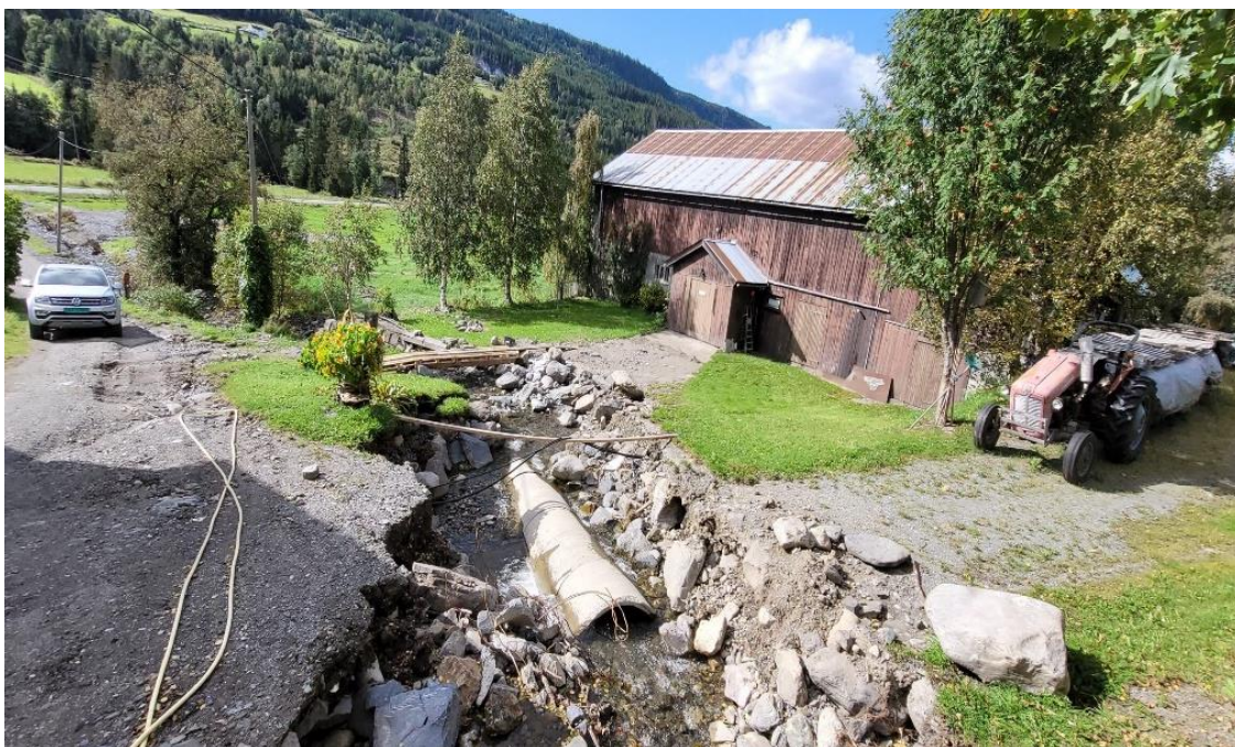
Utgravd bekkeløp og lukking gjennom tunet på Kårfald.
