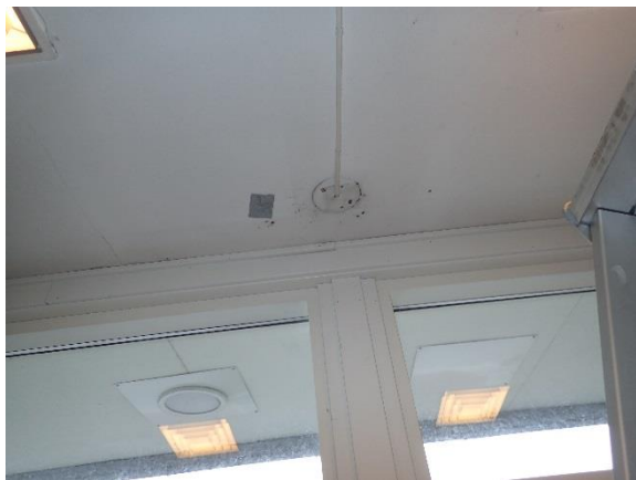
Bilde nr. 2.03 Bygg 1, Himlingsplater av asbestolux.
