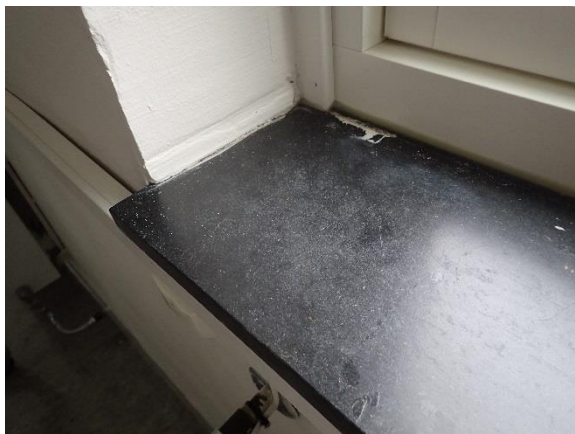
Bilde nr. 2.01 Bygg 1, Vindusbrett.
