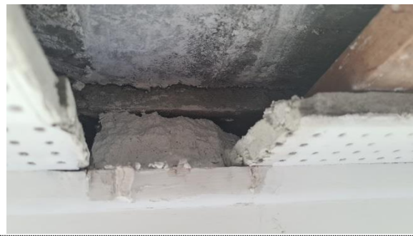
Bilde nr. 2.07 Helsebygg, himling og hvitt materiale over himling (ikkje asbest).
