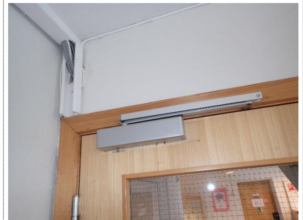
Bilde nr. 2.04 Bygg 1, støvprøve med asbestinnhold ble tatt på list over dør.
