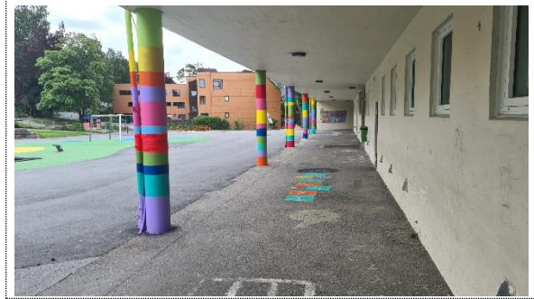
Bilde nr. 2.08 Bygg 1, søyler støpt i eternitrør, malt i mange farger.
