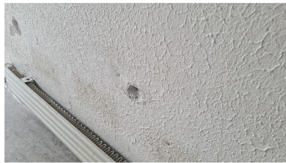
Bilde nr. 2.09 Bygg 1, strukturpuss (ikke asbest).
