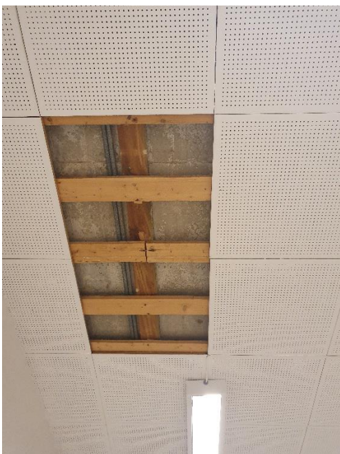
Figur 2 Etasjeskiller i betong. Dekke over 1. etasje.
