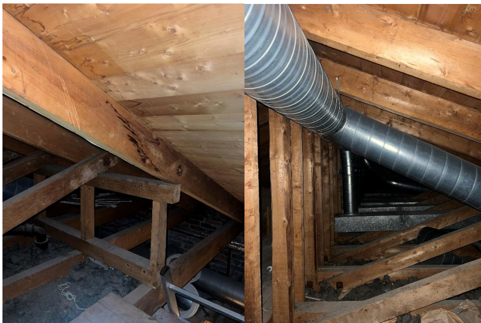
Figur 3 Takstoler på loft over 2.etasje.
