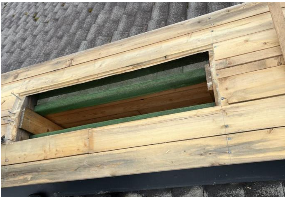
Bilde tatt ovenfra etter fjerning av blikk.
