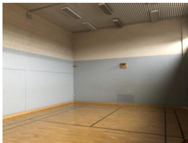
Bilde B8: Kontrollområde 8 i 1. etasje Gymsal rom 141
