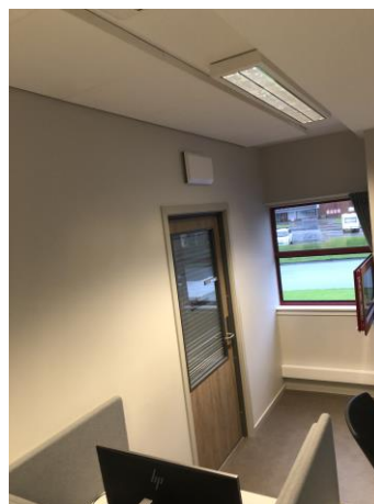
Bilde 4: Kontrollområde 4 Dør fra 2020 på rom 208 i 2. etasje skal fjernes og åpningen skal bygges igjen.
