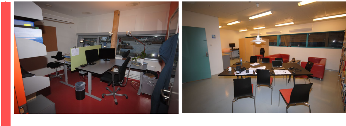
Figur 5 Eksempel på vinylbelegg i bygget. Til venstre: Første etasje, til høyre: tredje etasje.
