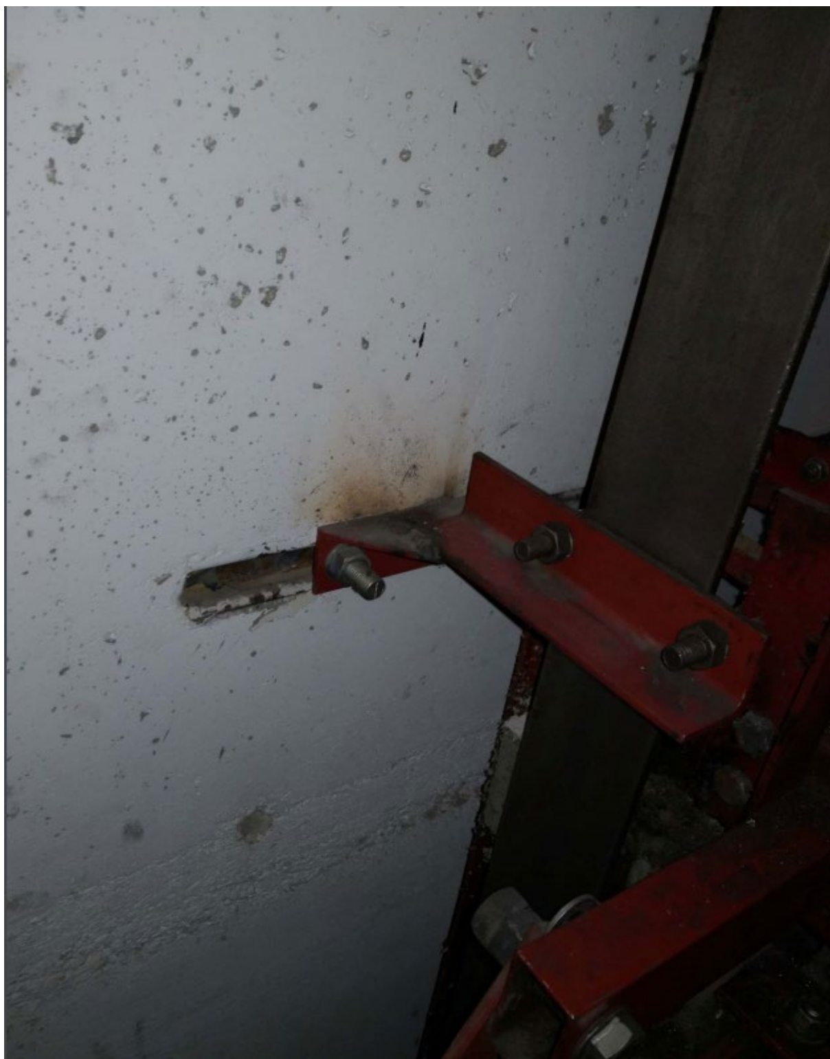
Figur 9 detalj sjakt, innfesting festejern, innstøpte halfen skinner
