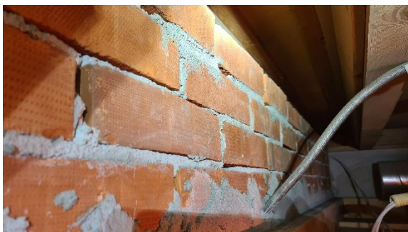
Bilde 7 – Hulltegl med sementmørtel.
