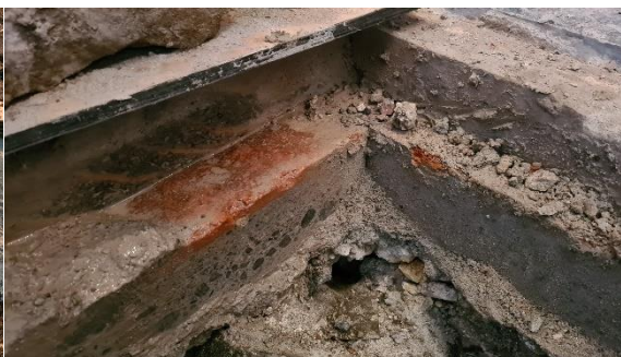
Bilde 6 – Dobbelt betonggulv i garderobe.
