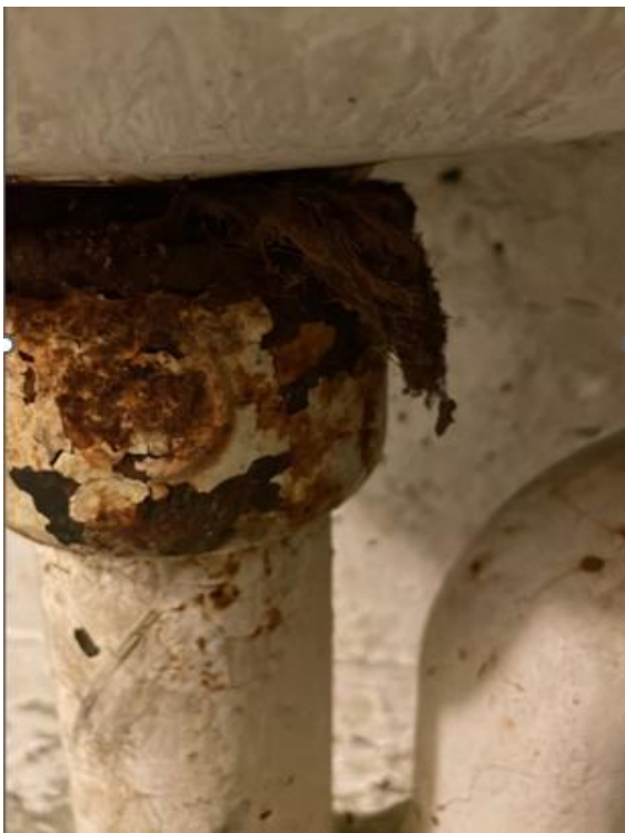
Bilde 2: Pakning rundt soilrør. Prøve P9
