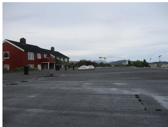
Bilde 31: Oversiktsbilde over taket
