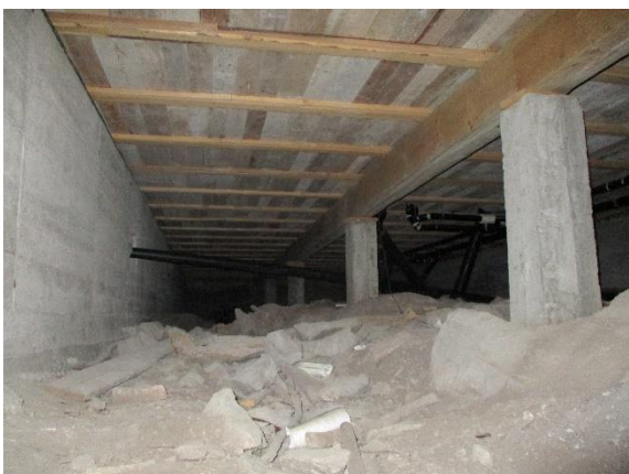
Bilde 40: Søyelfundamenter og betongvegg i krypkjeller. Prøve P23 og P24. Kan nyttiggjøres uten søknad.
