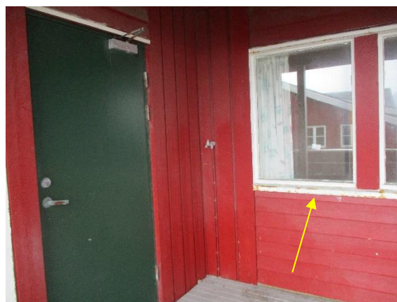
Bilde 35: Gul pil viser metallbeslag med maling
