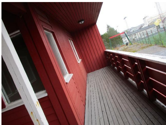
Bilde 16: Terrasse og søyler
