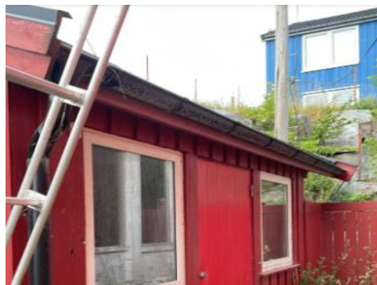
Bilde 33: Bod med asfaltpapp på tak
