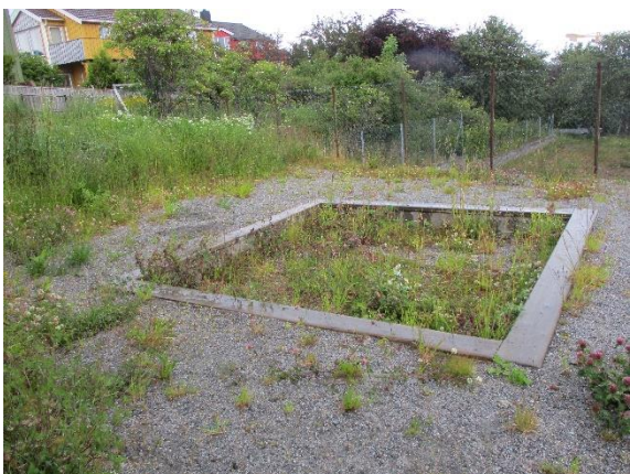
Bilde 20: CCA-impregnert materiale rundt sandkasse
