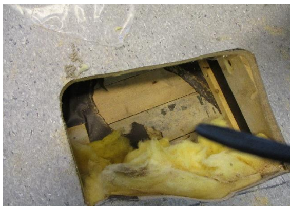
Bilde 7: Vindpapp i gulv. Prøve P27
