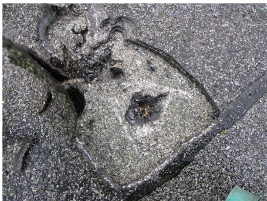
Bilde 30: Tre lag med asfaltpapp
