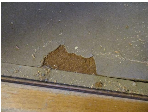
Bilde 4: Linoleum gulvbelegg. Prøvs P8b
