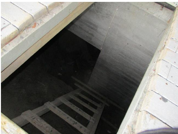
Bilde 18: Stige ned til krypkjeller
