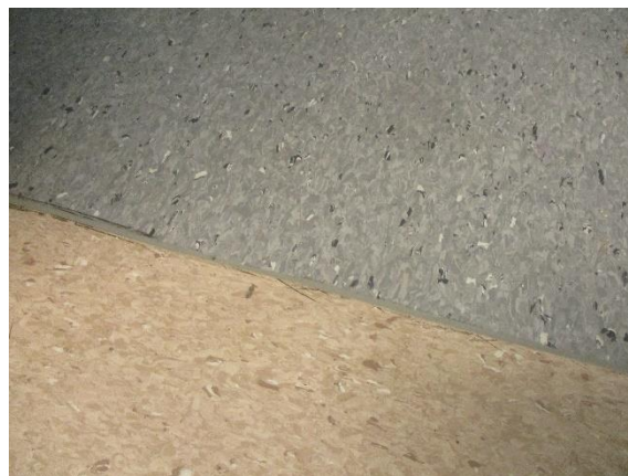
Bilde 29: Eksempel på fugemasse mellom vinylbelegg
