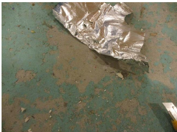
Bilde 36: Grønn maling på betonggulv. Prøve P1. Farlig avfall med bly og sink.
