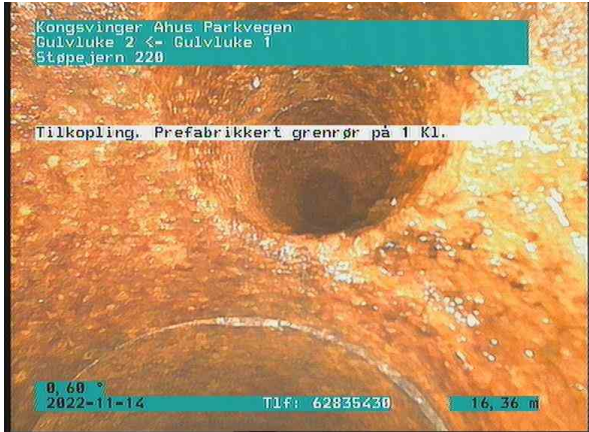
SP Bunnledning 4_Gulvluke 2_Gulvluke 1_14112022_084127_041.jpg, 00:05:33, 16.36m Tilkobling. Prefabrikkert grennrør på 1 Kl. / TKP 63
