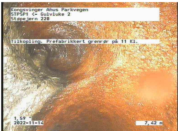
SP Bunnledning 3_DE 1_Gulvluke 2_14112022_095021_026.jpg, 00:01:47, 7.42m Tilkobling. Prefabrikkert grenrør på 11 Kl. / TKP 47
