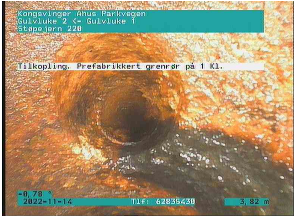
SP Bunnledning 4_Gulvluke 2_Gulvluke 1_14112022_084127_033.jpg, 00:01:28, 3.82m Tilkobling. Prefabrikkert grenrør på 1 Kl. / TKP 57
