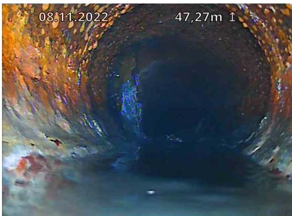
SP Bunnledning 2_Gulvluke 3_DE 1_08112022_071922_023.jpg, 00:08:15, 47.48m Dimensjonsendring til, S 225 mm
