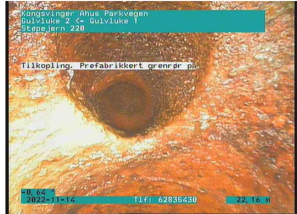
SP Bunnledning 4_Gulvluke 2_Gulvluke 1_14112022_084127_046.jpg, 00:07:30, 22.16m Tilkobling. Prefabrikkert grennrør på 11 Kl., 100mm / TKP 40 + TKP41 + TKP42
