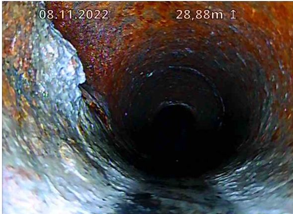
SP Bunnledning 2_Gulvluke 3_DE 1_08112022_071922_017.jpg, 00:04:49, 28.88m Tilkobling. Prefabrikkert grenrør på 11 Kl. / TKP 25, TKP 20 og TKP 32
