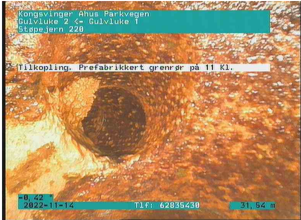
SP Bunnledning 4_Gulvluke 2_Gulvluke 1_14112022_084127_049.jpg, 00:09:08, 31.54m Tilkobling. Prefabrikkert grennrør på 11 Kl. / TKP43 + TKP34 + TKP35 + TKP 36
