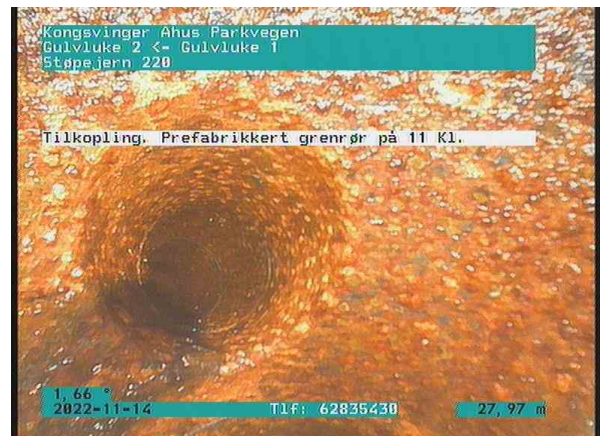
SP Bunnledning 4_Gulvluke 2_Gulvluke 1_14112022_084127_048.jpg, 00:08:36, 27.97m Tilkobling. Prefabrikkert grennrør på 11 Kl. / TKP39
