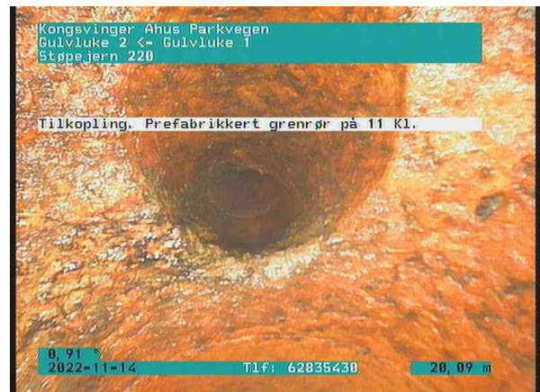
SP Bunnledning 4_Gulvluke 2_Gulvluke 1_14112022_084127_044.jpg, 00:06:36, 20.09m Tilkobling. Prefabrikkert grennrør på 11 Kl. / TKP 69 + TKP 68 + TKP 67
