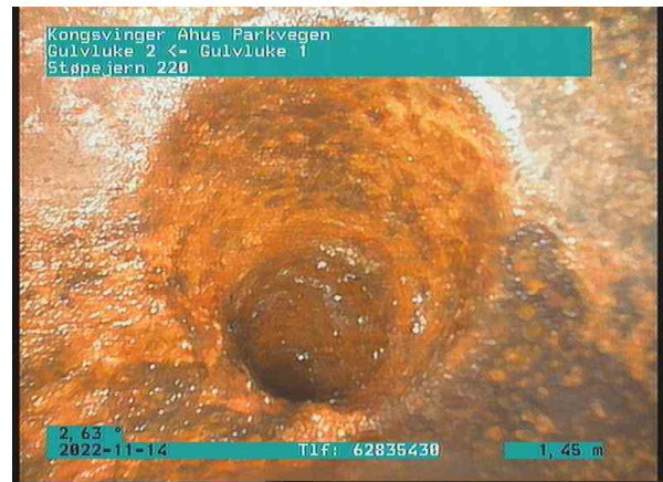
SP Bunnledning 4_Gulvluke 2_Gulvluke 1_14112022_084127_030.jpg, 00:00:19, 1.45m Tilkopling. Prefabrikkert grennrør på 11 Kl. / TKP 59
