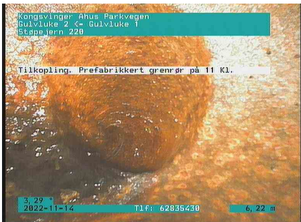
SP Bunnledning 4_Gulvluke 2_Gulvluke 1_14112022_084127_035.jpg, 00:02:14, 6.22m Tilkobling. Prefabrikkert grenrør på 11 Kl. / TKP 60
