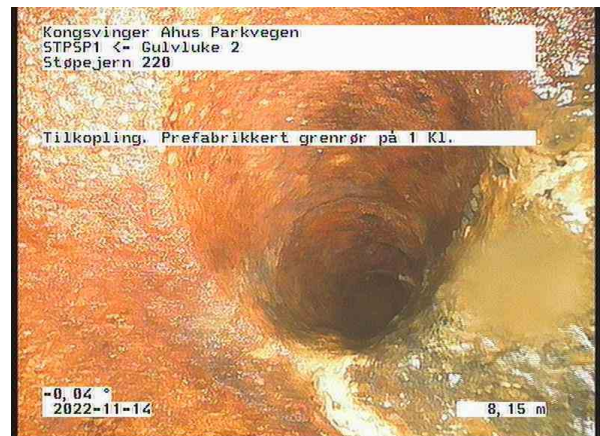
SP Bunnledning 3_DE 1_Gulvluke 2_14112022_095021_027.jpg, 00:01:59, 8.15m Tilkobling. Prefabrikkert grenrør på 1 Kl. / TKP 51
