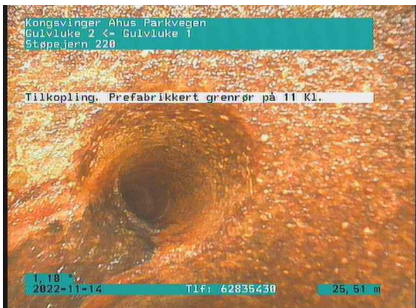
SP Bunnledning 4_Gulvluke 2_Gulvluke 1_14112022_084127_047.jpg, 00:08:08, 25.51m Tilkobling. Prefabrikkert grennrør på 11 Kl. / TKP 38
